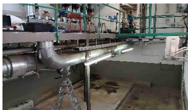
Heizraum nach Abbau der alten Anlage
