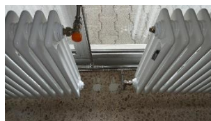
Erweiterung der Heizkörper im UG des Erweiterungsbaus 07 bis 09-2025
