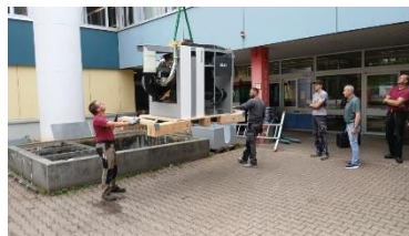
Einbringung des neuen Gasheizkessel mit Kran 06-2025
