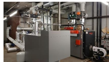
Neuer Gas-Brennwert-Heizkessel 07-2025
