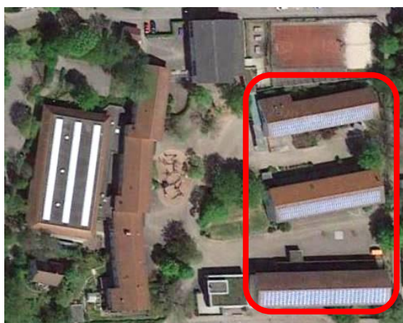
Hardtschule: Bestehende Bürger PV-Anlage mit ca. 72 kWp
