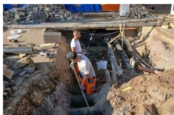
Einbringung der neuen Nahwärmeleitung 07 bis 08-2024
