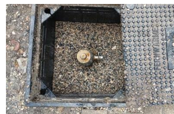
Erneuerte Sektionsabsperungen 07 bis 08-2024
