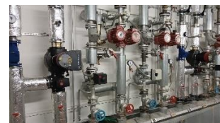
Teil-Erneuerung am Heizungsverteiler des Erweiterungsbaus 09-2025
