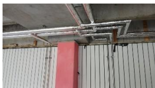
Erneuerung der Heizungsverrohrung im UG des Erweiterungsbaus 07 bis 09-2025
