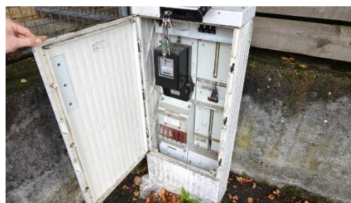
Einspeisezähler Unterbau
