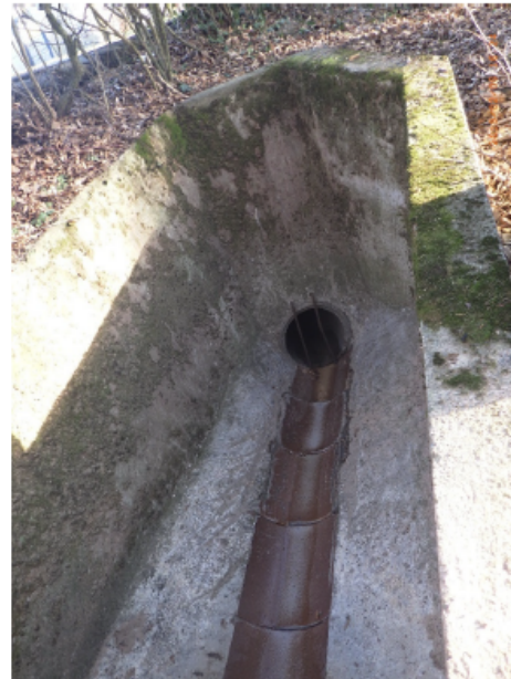
Abbildung 44: Verdolungseinlauf an der Kroatenklinge
